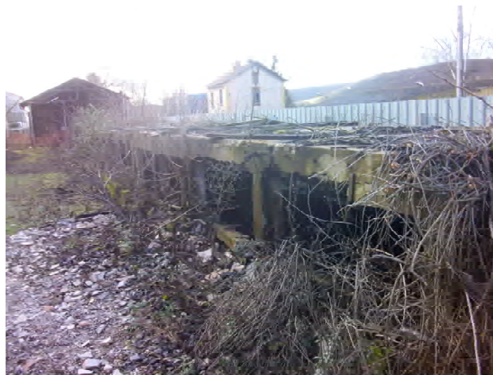
Zone de stockage des cuves RN, et rétention en structure béton
