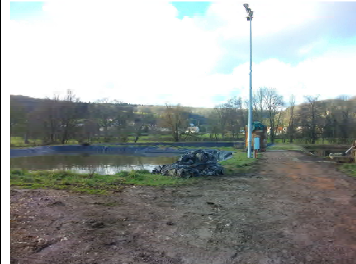
Entrée de la station d'épuration, avec vue sur le bassin n°2
