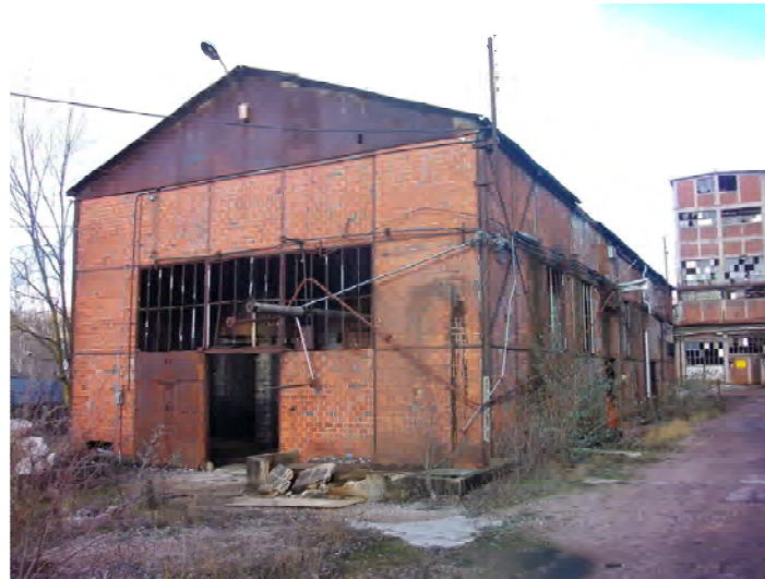
Alcoolerie discontinuée (bâtiment R1), et alcoolerie continue en arrière plan (bât. R)
