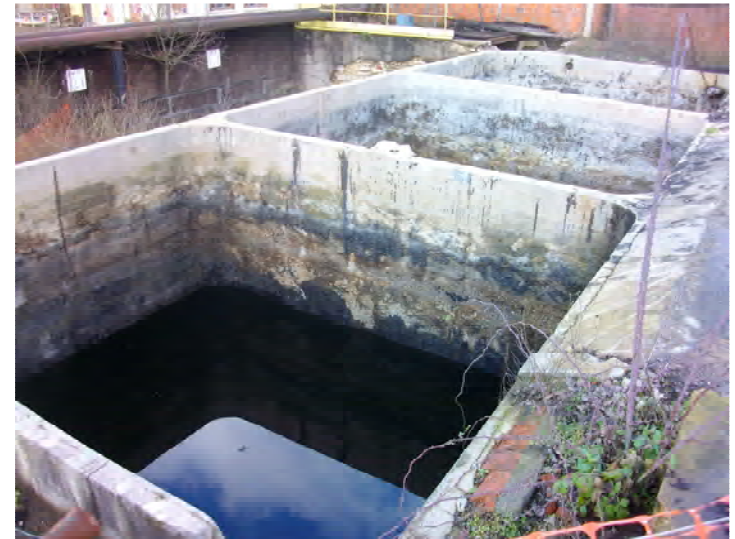
Fosses de collecte des eaux résiduaires (R2) avec présence d'eau noirâtre
