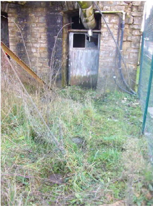
Zone R3 - accès vers la salle des pompes
