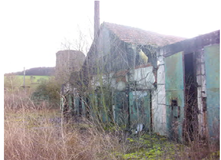
Tunnels du bâtiment C1 et tour maçonnée (C') en arrière plan
