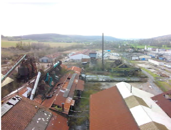
Vue générale du secteur Charbon depuis le pré-séchoir A5
