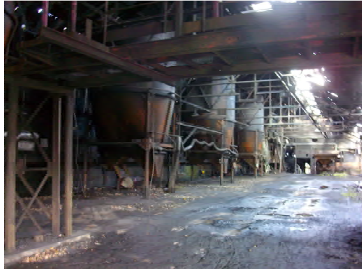
Intérieur du bâtiment B : Conditionnement des charbons de bois avec cuves aériennes en acier
