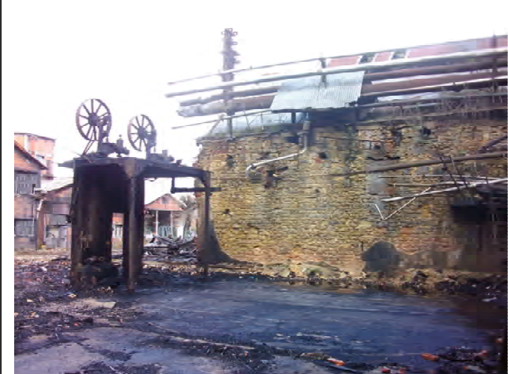
Localisation de l'ancienne cuve de jus pyroligneux (cuve A4) à proximité du bâtiment I
