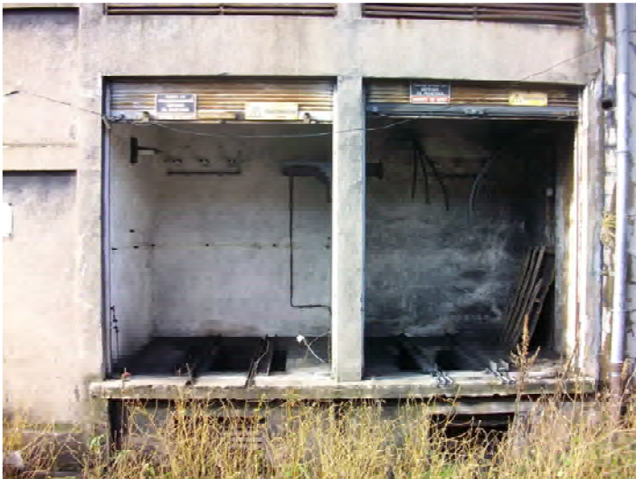
Anciens postes de transformation, à l'arrière de la centrale à gaz (bâtiment F)
