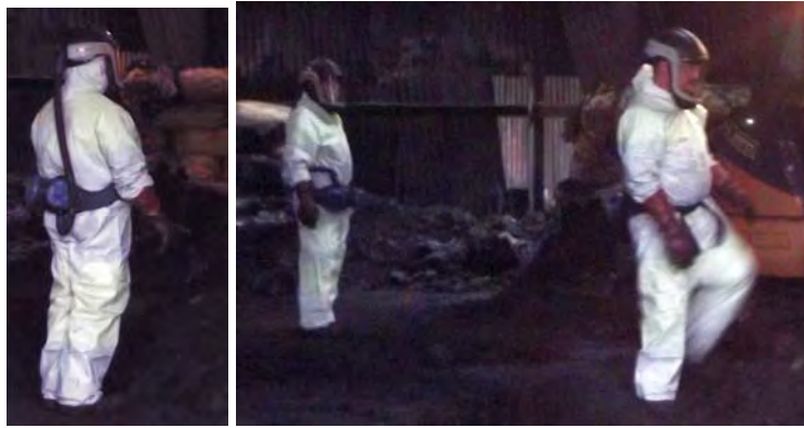
Figure 7 Exemple de protection minimale pour les opérations de curage
