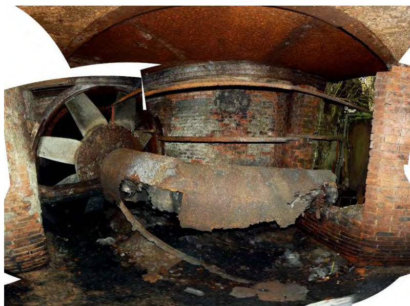
Ventilateur. L'accès à la galerie s'effectue par le trou à droite
