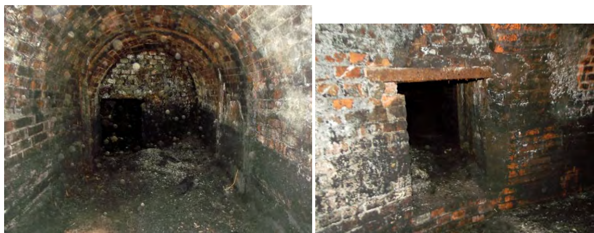
A gauche vue depuis le four – A droite vue depuis la galerie principale
