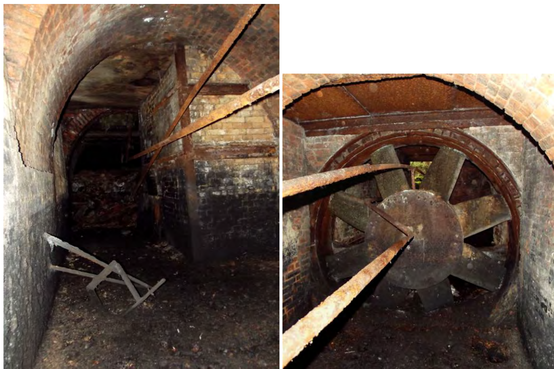
A gauche galerie principale devant le ventilateur – A droite vue du ventilateur depuis la partie basse du four stein
