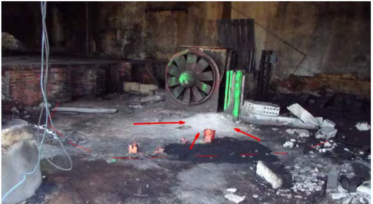
Figure 19 Flocage au sol - bât Créosote – (Amosite + chrysotile)
