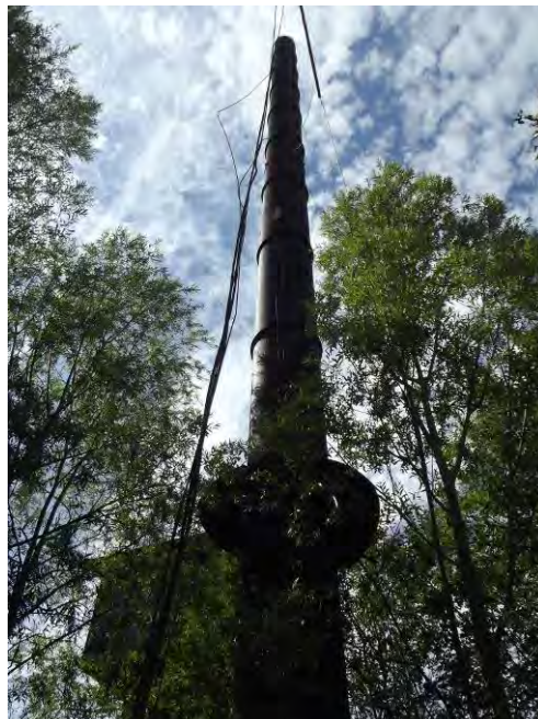
Figure 31 La cheminée métallique zone C Cheminée
