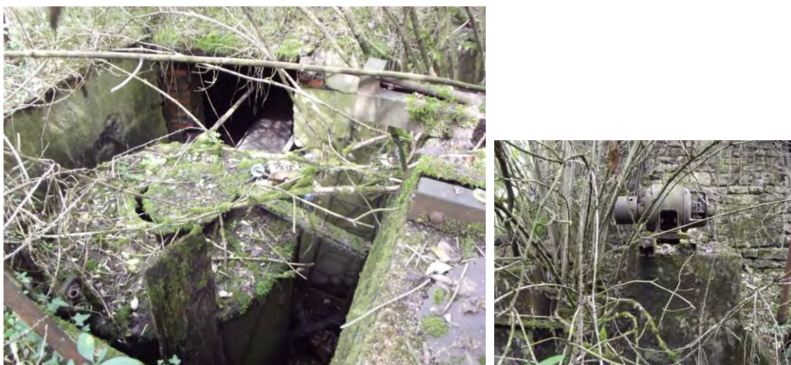
Figure 37 Fosse avec sa cuve et blocs béton + moteurs
