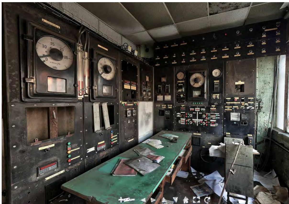
Figure 4 Panneaux de la salle de contrôle des fours à déposer
