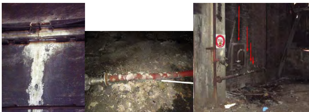
Figure 22 Exemple de dégradation du calorifuge plâtre amiante
