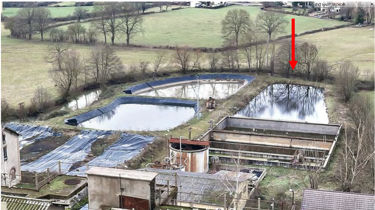
Figure 39 Vue de la station d'épuration
