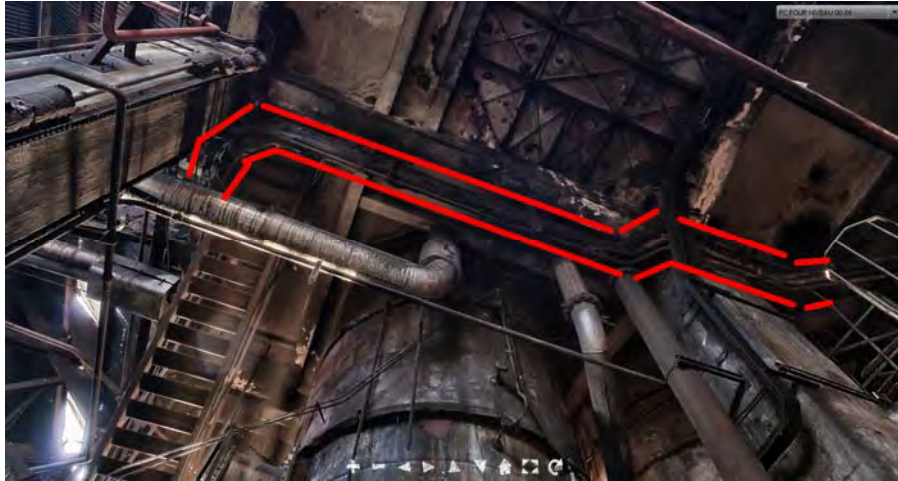
Figure 23 Suspicion de présence de canalisation plâtre amiante (Cf FC FOUR Niveau 00 04)
