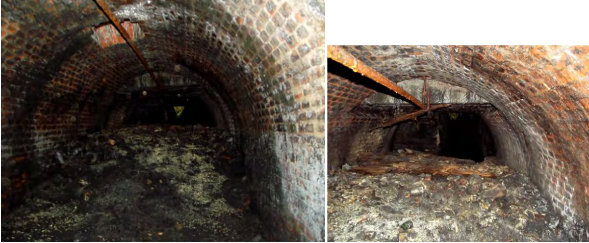
Vue de la galerie principale depuis la petite ouverture vers le four n° 2. Les déblais correspondent à une ouverture en surface devant le four stein et l'ancienne chaudière
